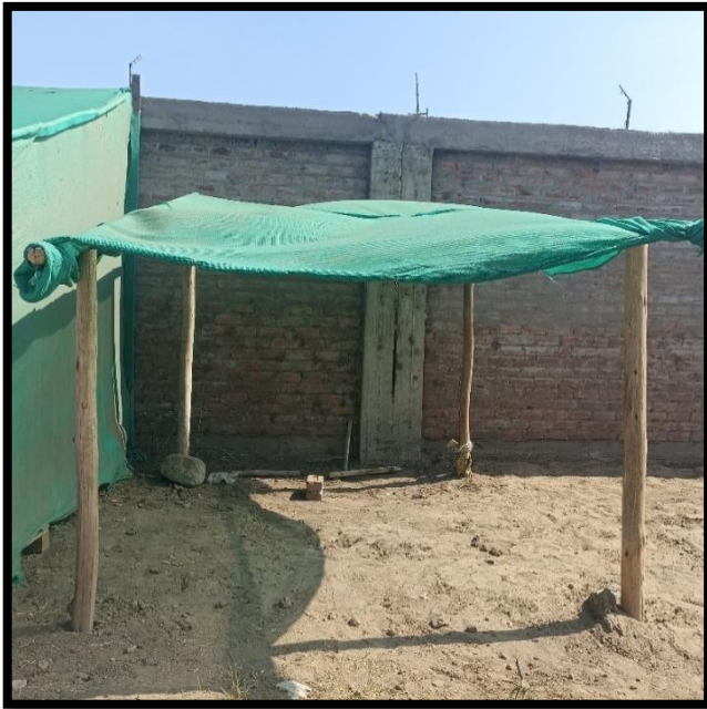
Figura 4. Instalación de techado y cortinas alrededor
