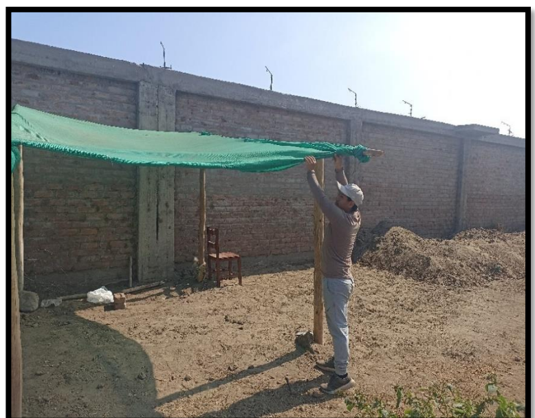
Figura 3. Colocación de parantes
